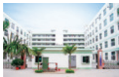
Завод в г.Сямынь
