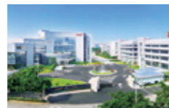
Завод в г.Сямынь
